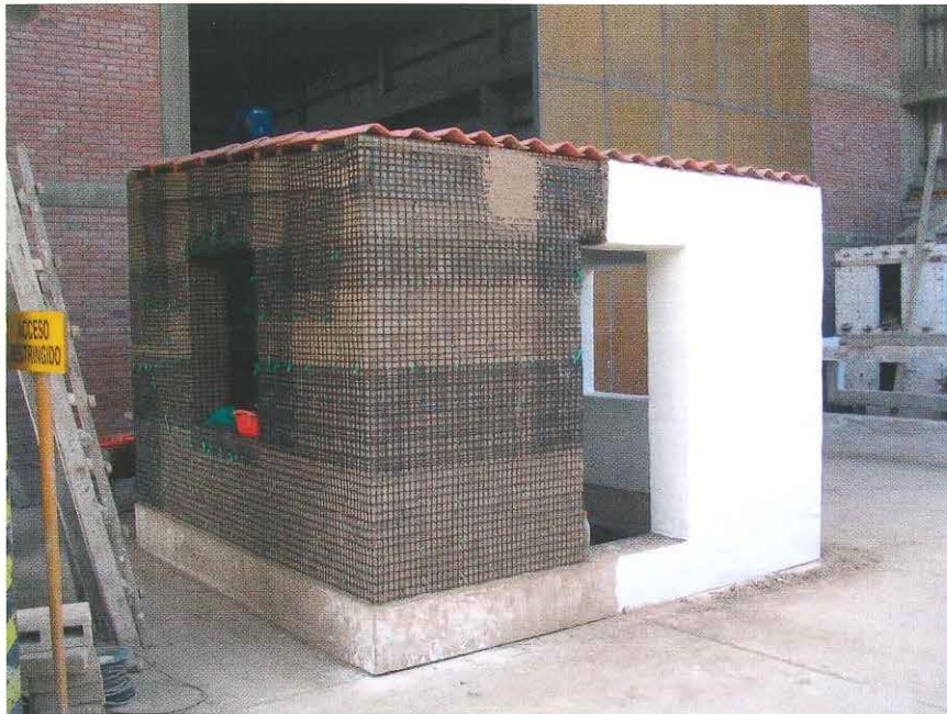
Figura 4. Módulo de adobe reforzado con geomalla y parcialmente tartajado, antes del ensayo de simulación
