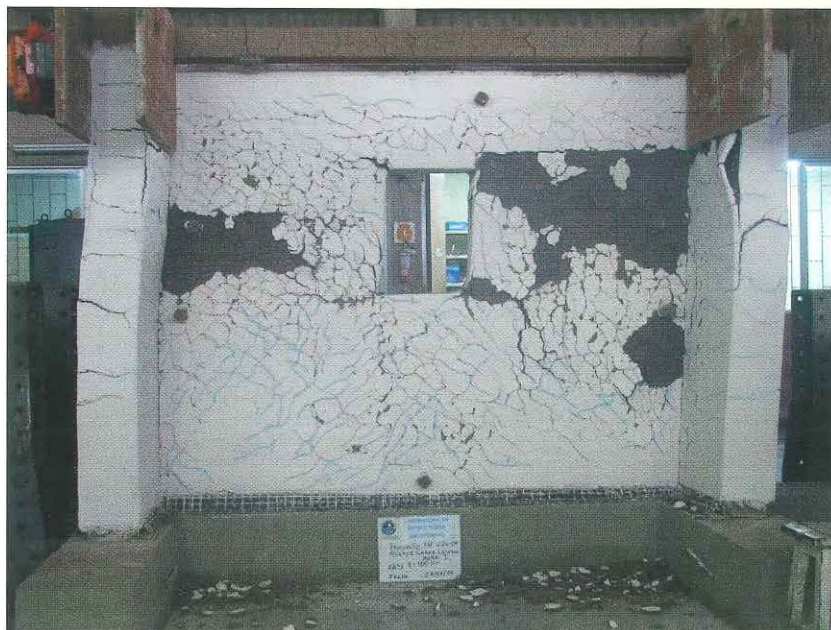
Figura 9. Muro enmallado y tarrajado ensayo de corte cíclico horizontal.
