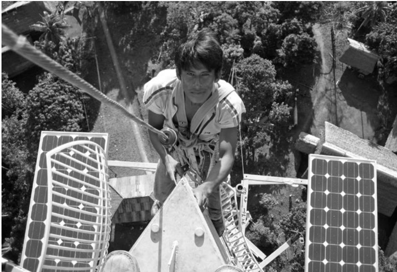
Figuras 1. Instalación de paneles fotovoltaicos y antenas IEEE802.11 en Angoteros, ribera del río Napo, Loreto, marzo de 2007
