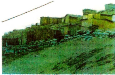
Figura 5. Vivienda en ubicaciones de riesgo.
