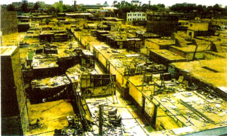
Figura3. Vivienda deficiente en callejones limeños/ Fuente: Maquet, 1998, p. 17.
