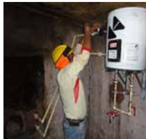
Fig. 1: Técnico durante instalación
