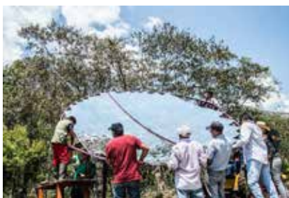
Fig. 3: Instalación de Concentrador Solar Scheffler
