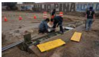
Fig. 3: Instalación de Equipo final Rompemuelle Bomba en Pachacamac
