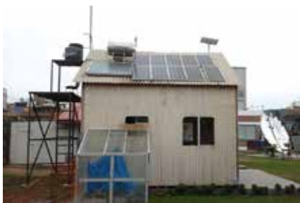
Fig. 2: Tecnologías que integran la vivienda.
