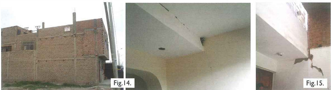
Fig.13. Primer piso de adobe y segundo piso de albañilería. Pisco.
