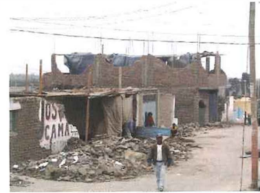
Fig.20. Muros sin diafragma rígido.
