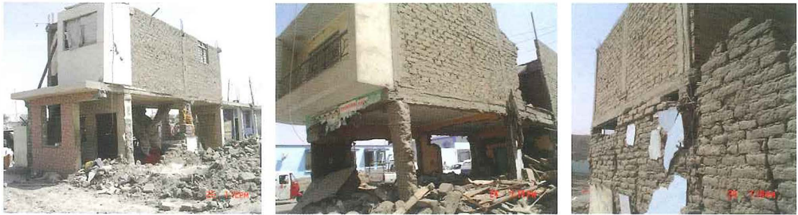
Fig.13. Primer piso de adobe y segundo piso de albañilería. Pisco.
