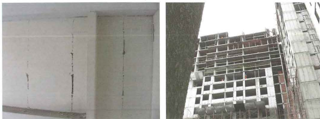
Fig.28. Tabique hecho con el sistema P-7.
