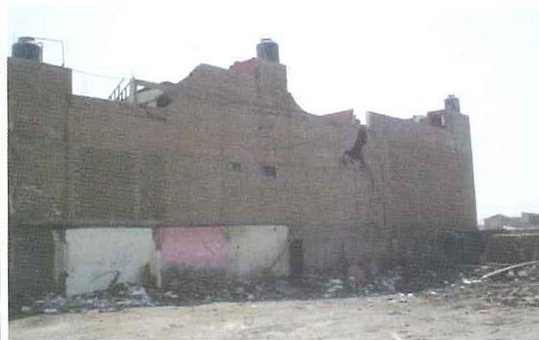
Fig.21. Muros sin solera y con columna discontinua (izquierda), y espaciamiento entre arriostres verticales muy grande (derecha).
