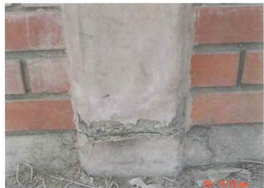
Fig.23. Pisco, cerco alto y rótula en la base de la columna de arriostre.
