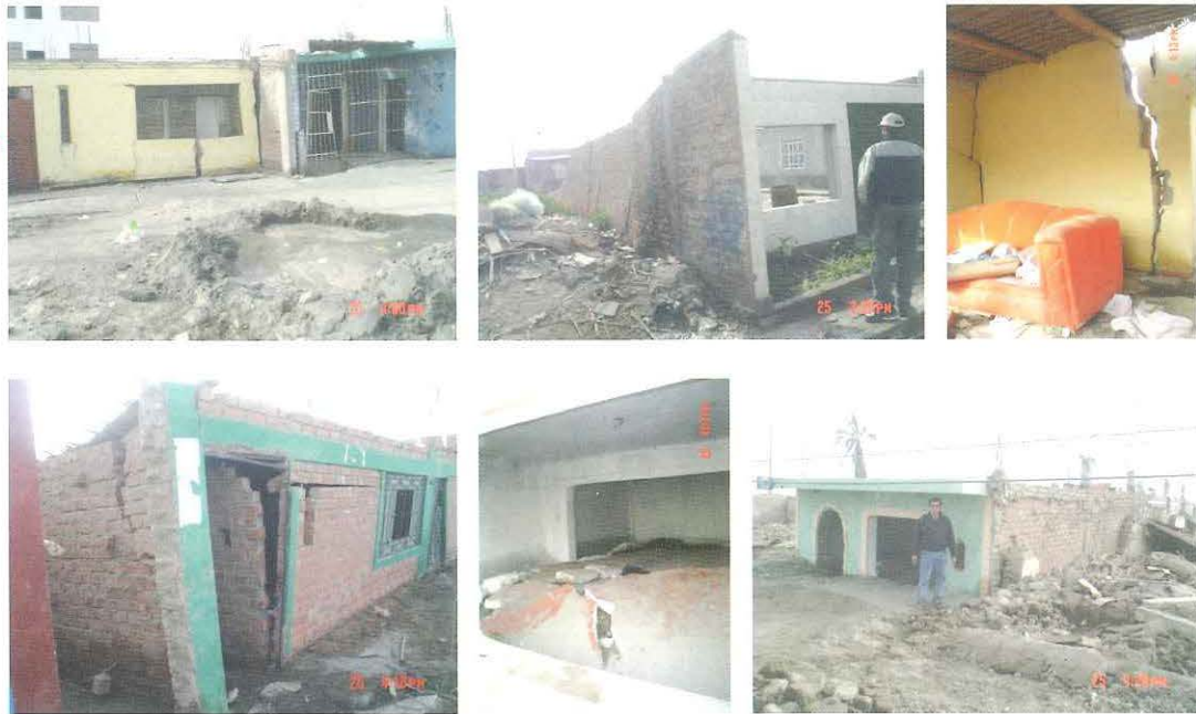
Fig.4. Licuación en el humedal de Tambo de Mora.
