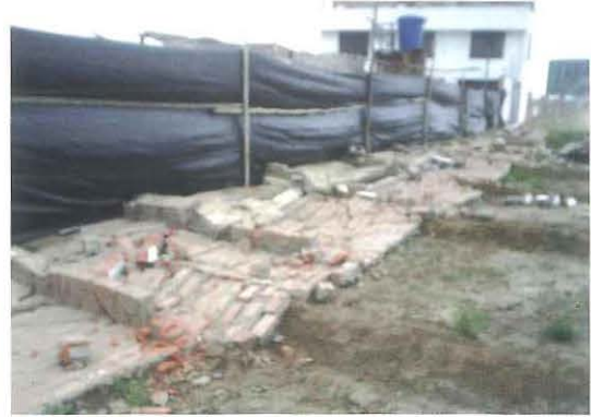
Fig.22. Chilca, columna sin refuerzo (izq.) y con mochetas (der.)
