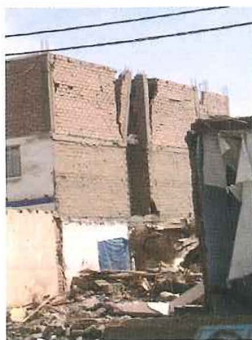
Fig.21. Muros sin solera y con columna discontinua (izquierda), y espaciamiento entre arriostres verticales muy grande (derecha).
