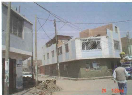
Fig.25. Pisco, parapeto sin arriostre (izq.) y arriostrado en el tercer piso (der.).
