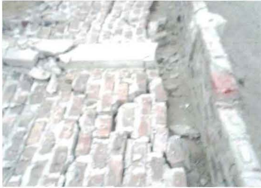
Fig.22. Chilca, columna sin refuerzo (izq.) y con mochetas (der.)
