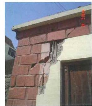
Fig.22. Unión columna-viga, nudo sin estribos. La Norma E.070 obliga a colocar por lo menos 2 estribos.
