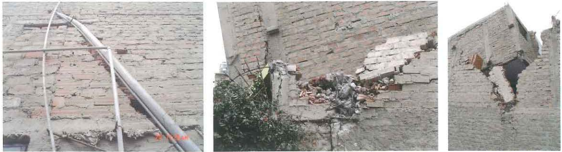
Fig.8B. Ladrillo pandereta en Pisco.
