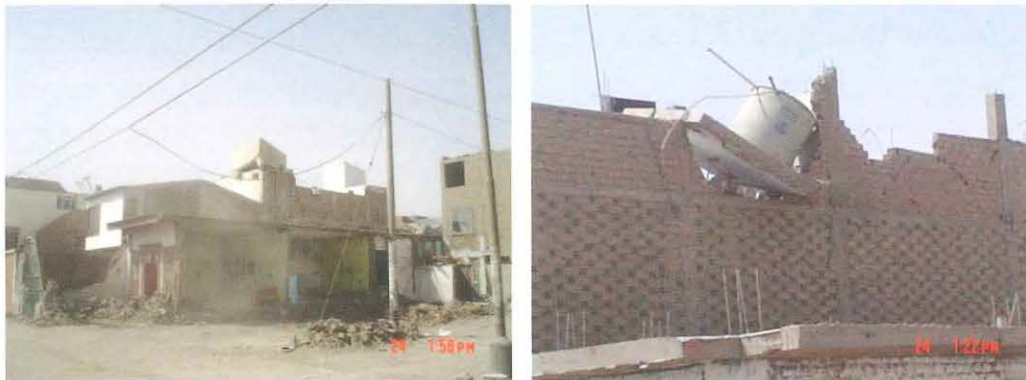
Fig.26. Pisco, colapso de tanques elevados.
