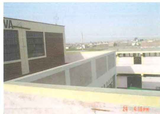
Fig.25. Pisco, parapeto sin arriostre (izq.) y arriostrado en el tercer piso (der.).
