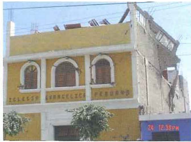
Fig.20. Muros sin diafragma rígido.
