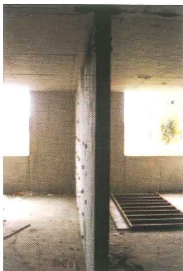
Foto 1. Vista de un muro
