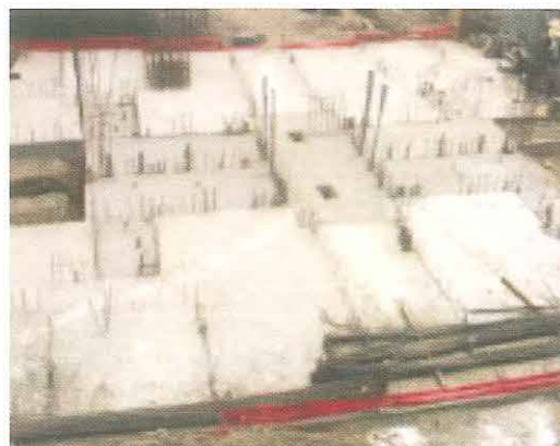
Foto 2. Vista Platea de Cimentación
