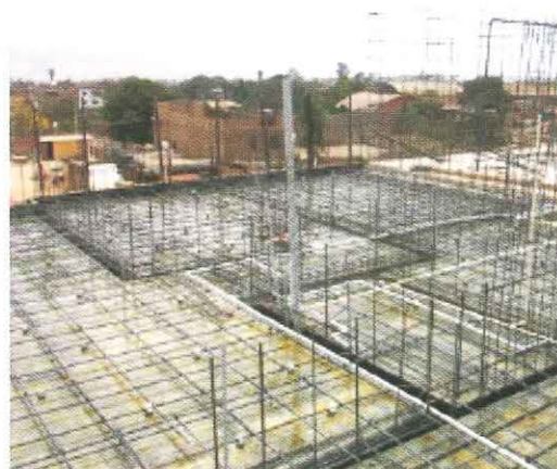
Foto 4. Vista de Losa de Techo
