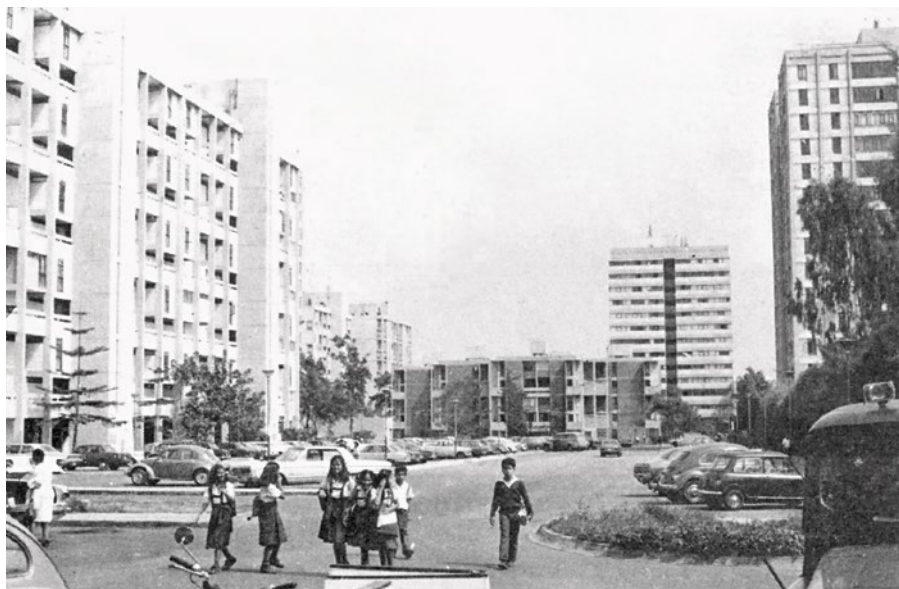
Conjunto Residencial San Felipe. Espacio interior con estacionamiento. (c. 1981)
