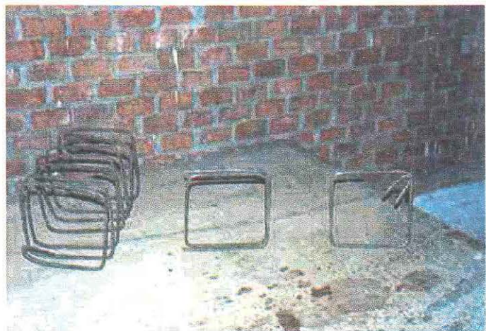
Foto 2. Estribos tipo zuncho, con 1\frac{3}{4} de vuelta y con gancho.
