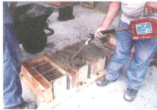
Foto 5. Vaciado y vibrado del concreto
