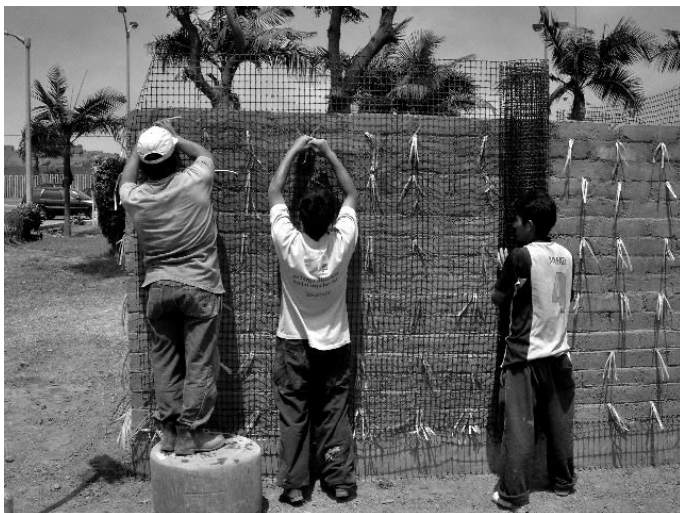
Figura 2. Refuerzo con geomalla en muros de adobe
