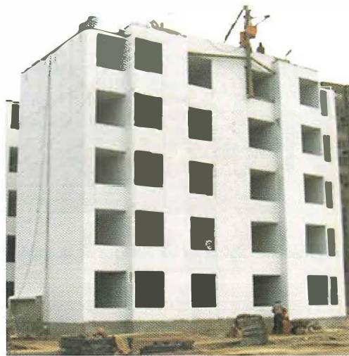
Figural. Fachada típica de un edificio de ductilidad limitada
