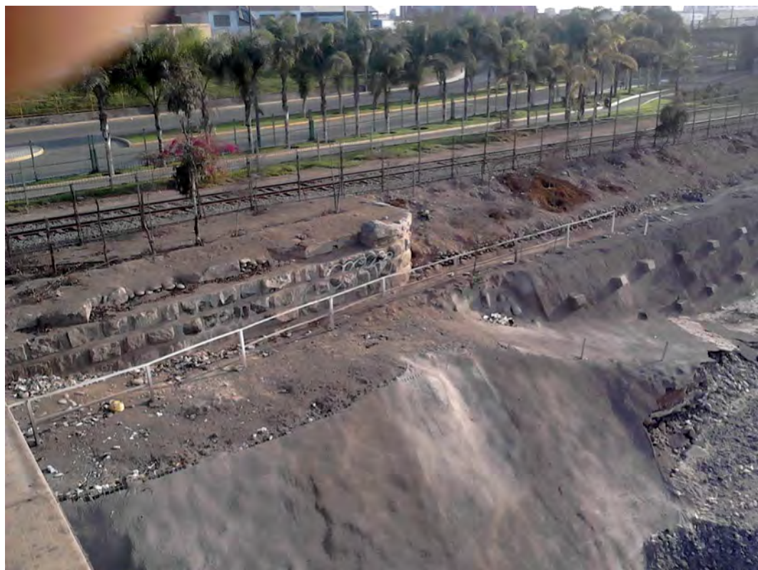
Figura 9. Vista del muro que definía la toma del canal La Legua, por donde ingresaba el agua desde el canal de captación.
