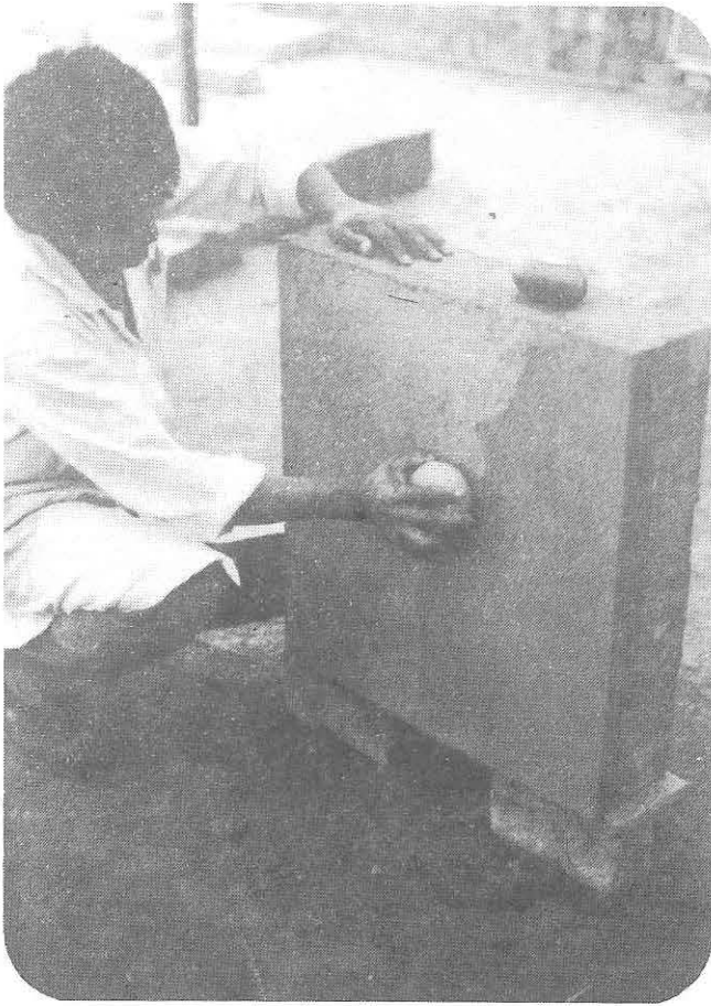
Fig. 2.2 Pulido de la Superficie del Enlucido.
