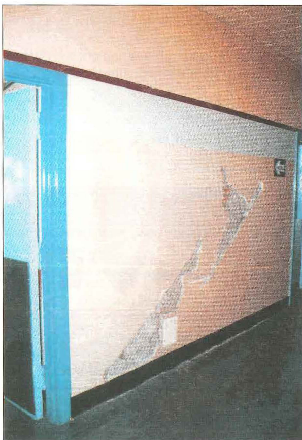
Foto 21. Los tabiques del Hospital Carlos Alberto Segúin controlaron los desplazamientos laterales y disiparon energía durante el sismo.
