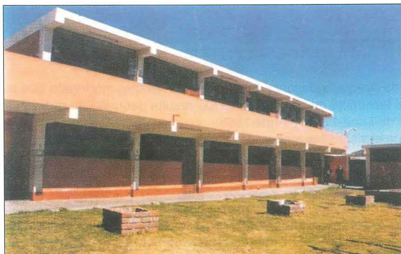
Foto 41. Pabellón tradicional aporticado sin daños gracias al muro de cierre completo en la cara paralela a la fachada principal.
