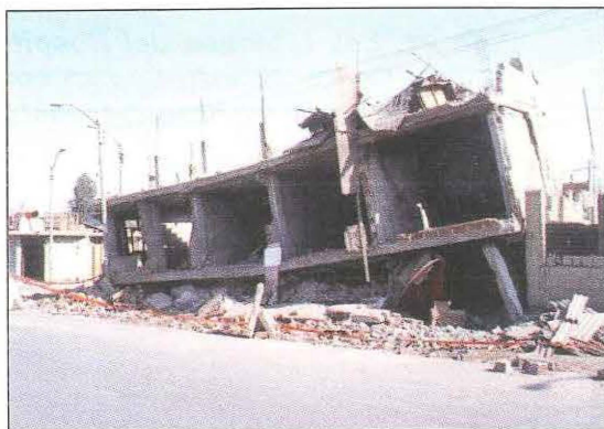
Fotos 24 y 25. Viviendas colapsadas de tres pisos en albañilería y concreto armado, Tacna.
