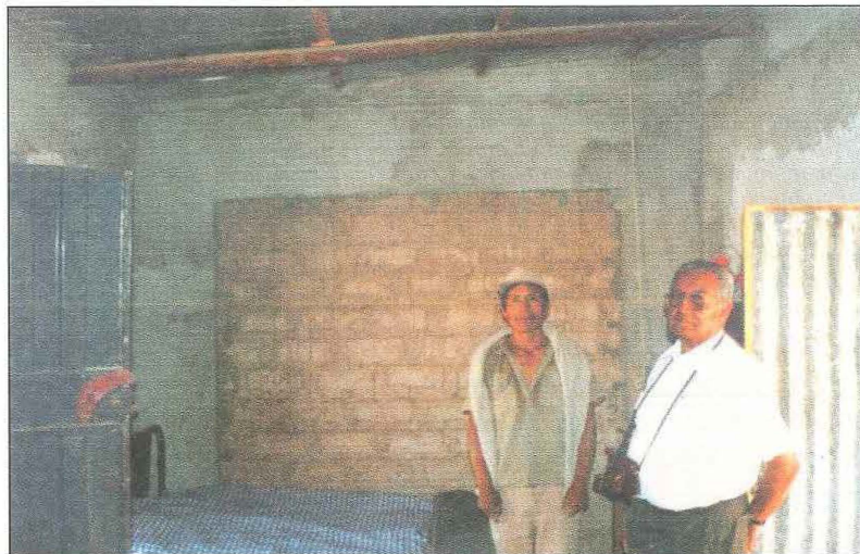
Foto 39. Reforzamiento de viviendas de adobe existentes empleando franjas de malla electrosoldada tarrajada, poblado de Yacango, Moquegua.
