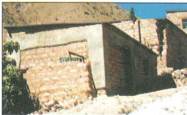
Foto 40. Vivienda reforzada sin daño junto a otras muy dañadas, Yacango, Moquegua
