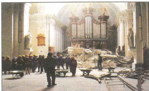
Foto 31. La torre izquierda de la Catedral de Arequipa perforó el techo en su caída.
