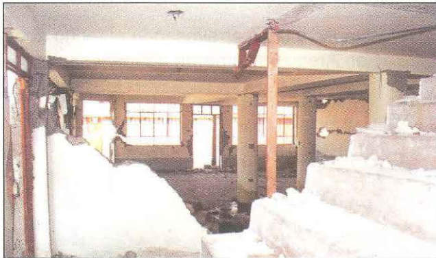
Fotos 26 y 27. Viviendas de albañilería y concreto armado con daño irreparable, Tacna.
