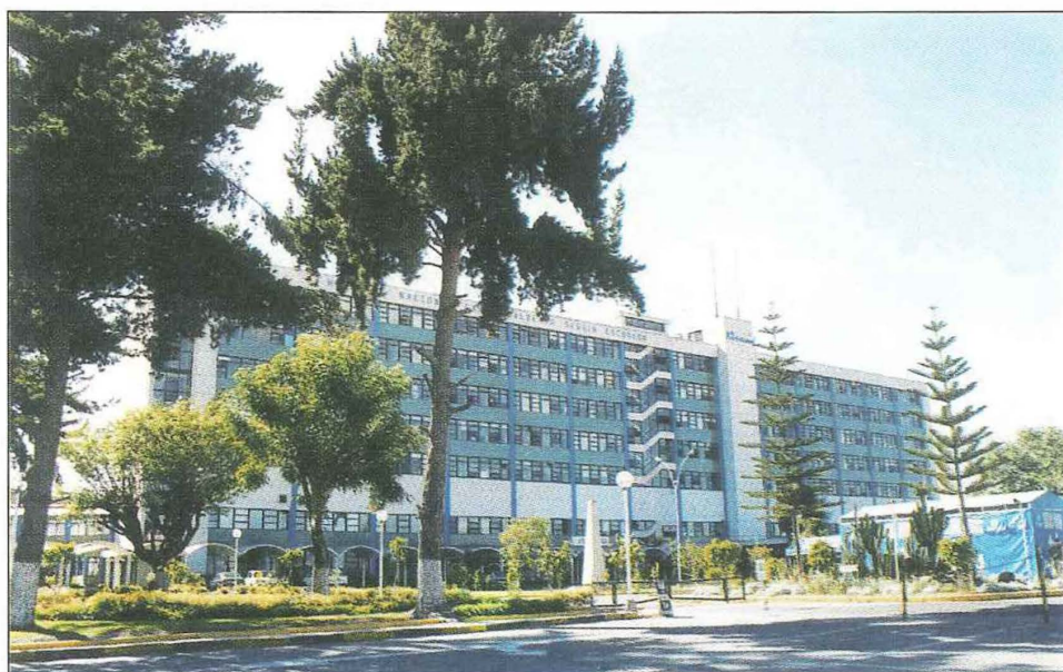
Foto 16. Hospital Nacional Carlos Alberto Seguí de Arequipa sin daño estructural pero desalojado por daños en la tabiquería.
