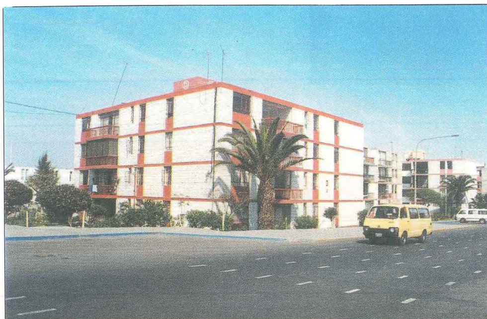
Foto 38. Edificio de departamentos muy rígido y antiguo sin daños en Tacna.
