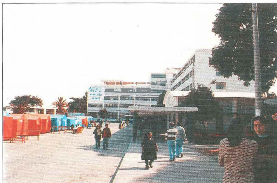
Foto 19. Desalojo en el Hospital Hipólito Unanue de Tacna por daños no-estructurales.
