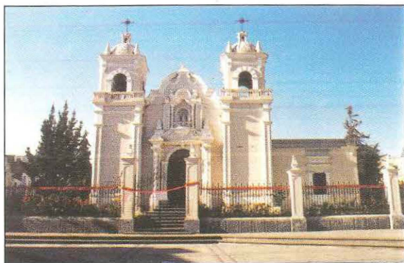
Foto 32. Las torres de la Iglesia de Santa Marta de Arequipa, sufrieron daños al proteger el cuerpo central.
