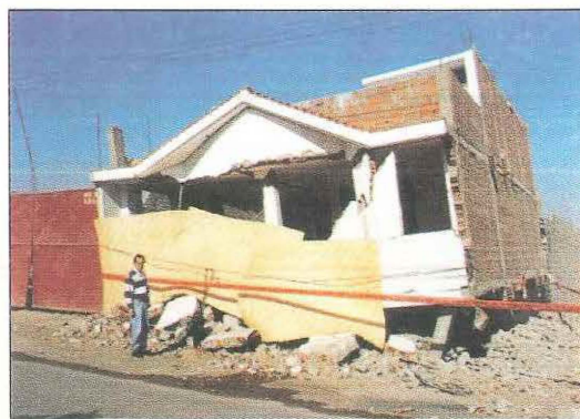
Fotos 24 y 25. Viviendas colapsadas de tres pisos en albañilería y concreto armado, Tacna.
