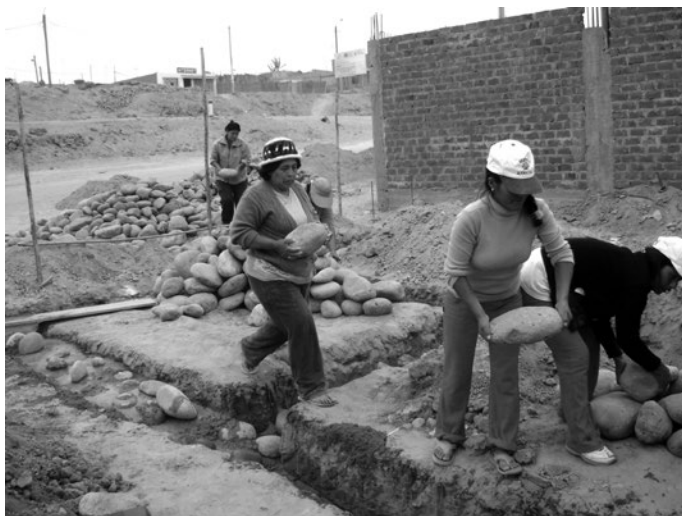
Figura 8. Construcción de casas de adobe reforzado
