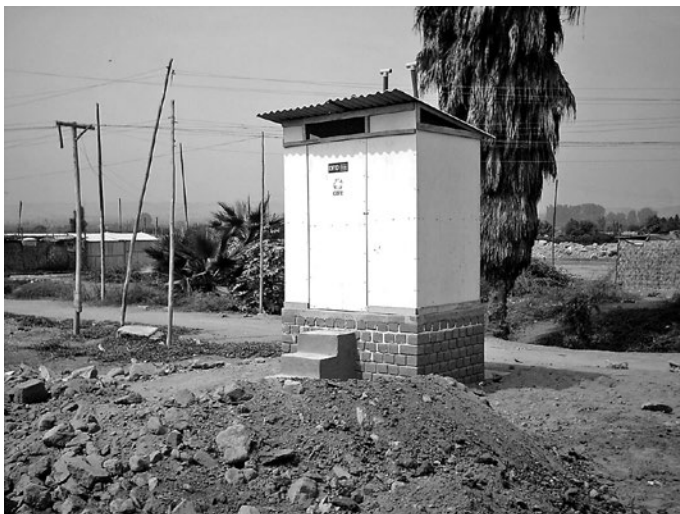
Figura 3. Letrina de hoyo seco ventilado
