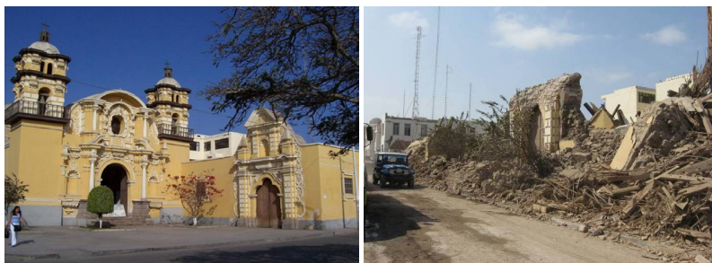
Figura 3. Iglesia de la Compañía de Jesús antes (izquierda) y después (derecha) del terremoto de Pisco de 2007.
