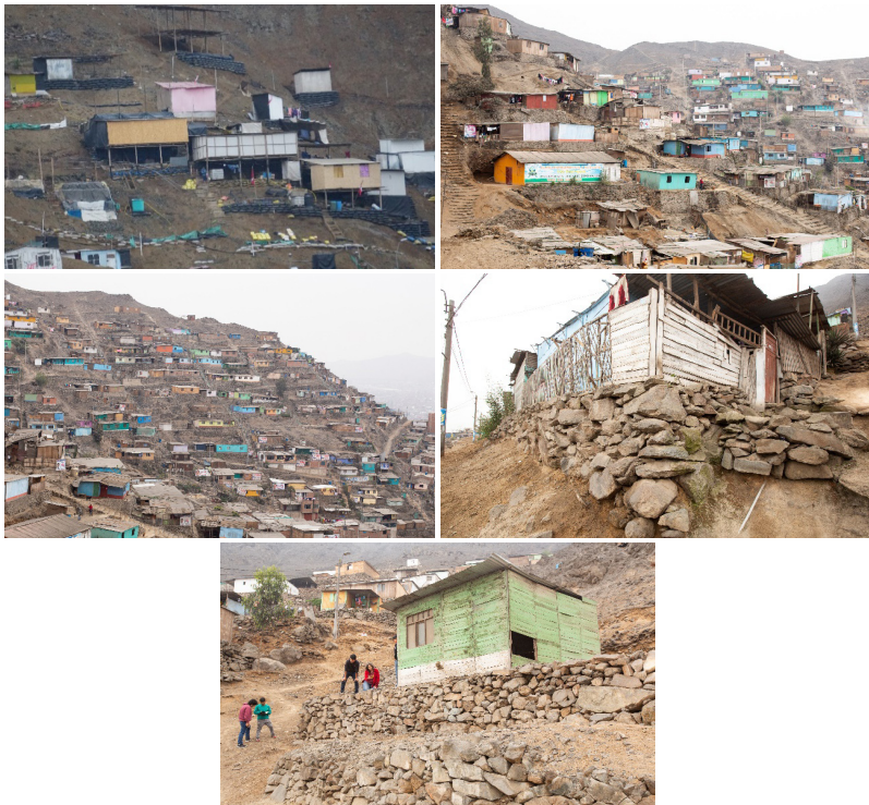
Figura 2. Viviendas precarias construidas en zonas de laderas.
