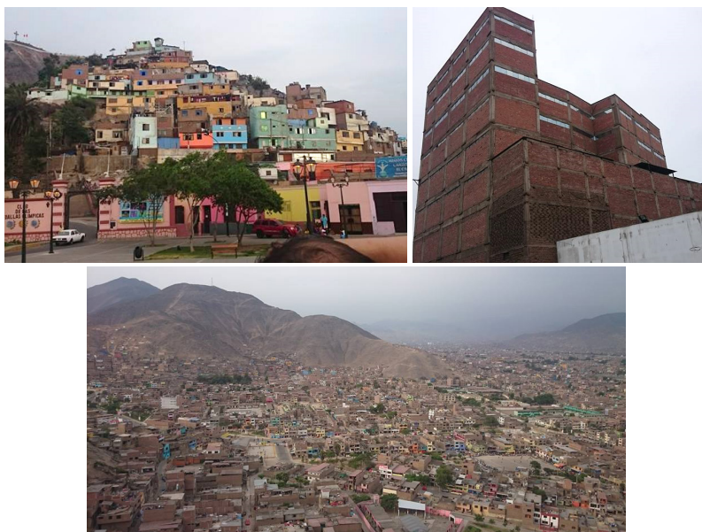
Figura 1. Viviendas de ladrillo construidas en algunas zonas de Lima
