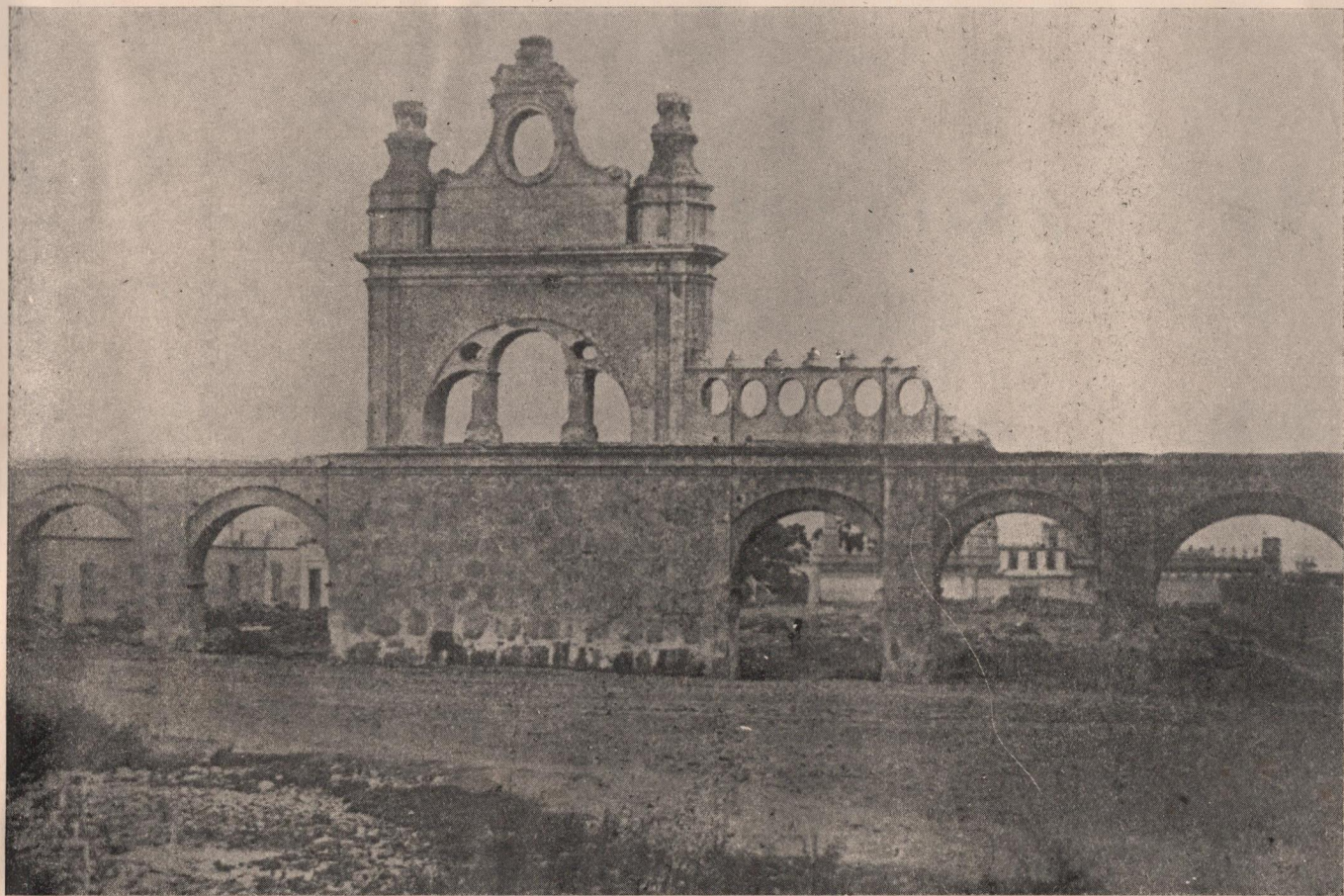
Vista del Paseo de Aguas antes de su reconstrucción.
