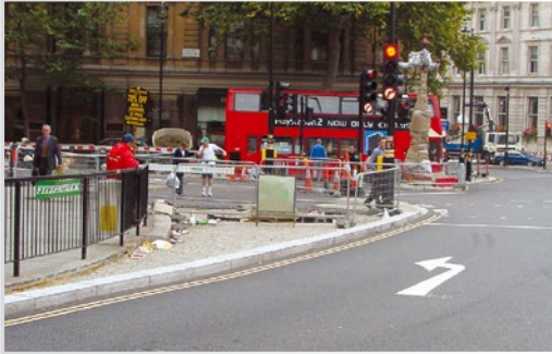
Figura 2: Reducción del radio de giro en una vía del centro de Londres (Trafalgar Square) para disminuir la velocidad de los vehículos y proteger la circulación de peatones y ciclistas.
