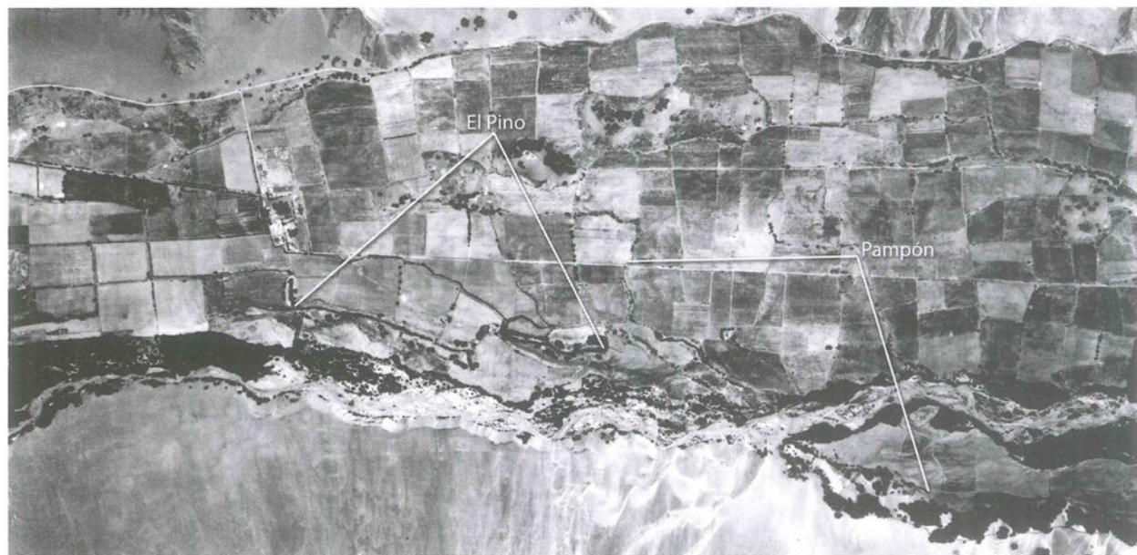
Figura 8.7. Fotografía aérea de los puquios El Pino y Pampón, tomada en 1944. (Foto: SAN 524-875)
