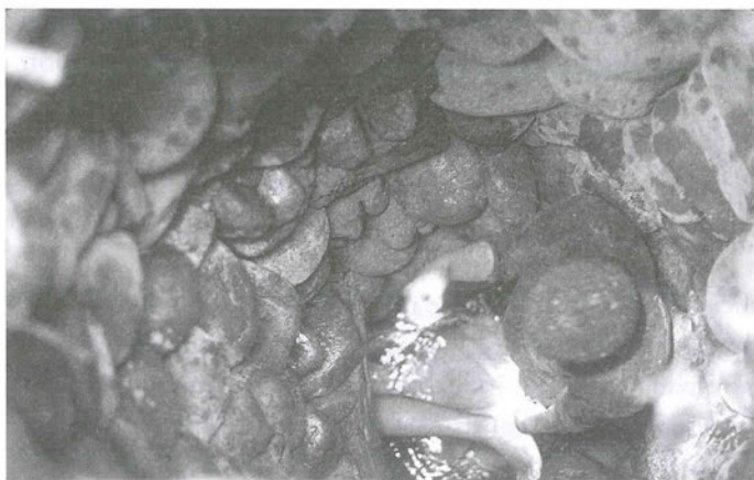
Figura 3.5. Limpieza de la galería del puquio Bisambra. El primer trabajador se para en el asiento del ojo, mientras que el segundo, cuya parte inferior de la pierna es visible en la foto, entra en la galería y la limpia de sedimento y escombros. El material se recoge en sacos plásticos (originalmente empaques de arroz) y se van entregando al primer trabajador, quien a su vez los traspasa a los que permanecen en la superficie. (Foto: Schreiber, 1986)
