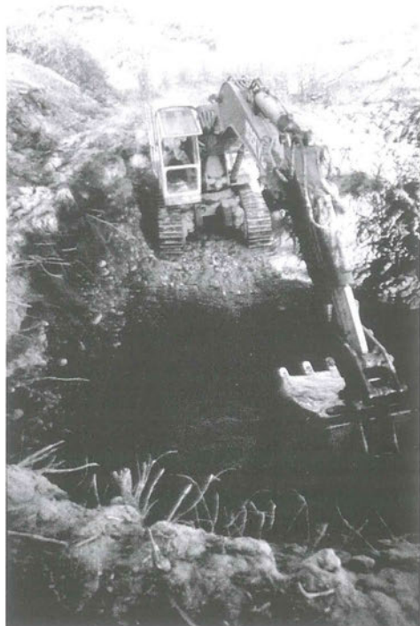
Figura 3.13. Excavación de un pozo-cocha en el valle de Las Trancas. (Foto: Schreiber, 1987)
