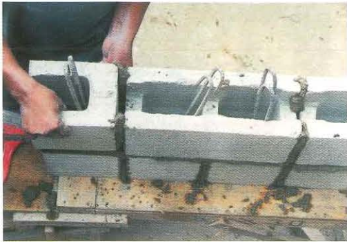
Foto 6. Construcción de la segunda hilada de la viga de albañilería. Nótese los estribos.
