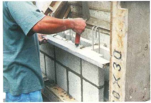
Foto 6. Construcción de la segunda hilada de la viga de albañilería. Nótese los estribos.
