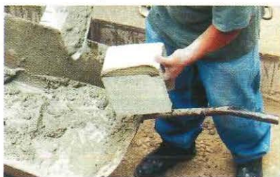
Foto 5. Construcción de la primera hilada de la viga de albañilería. Nótese la junta vertical.
