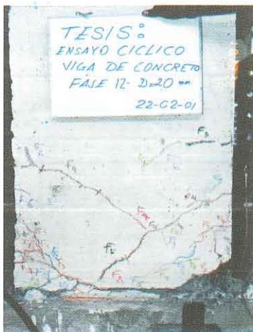
Foto 13. Patrón de fallas en la viga de concreto
