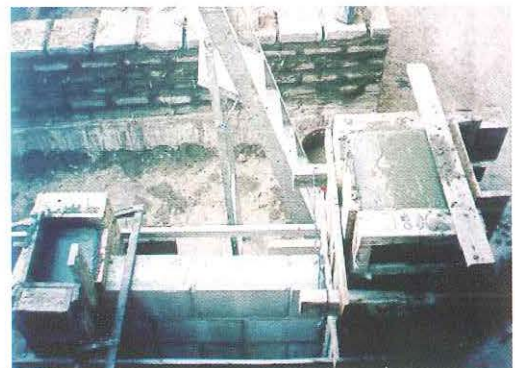
Foto 9. Construcción de la base y Corona de la viga de albañilería
