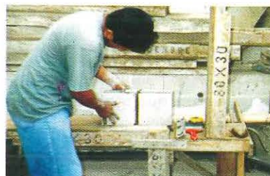
Foto 5. Construcción de la primera hilada de la viga de albañilería. Nótese la junta vertical.
