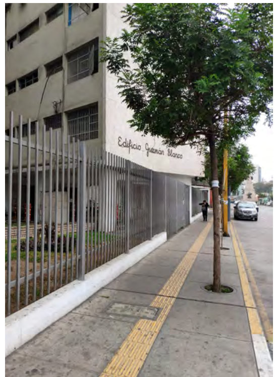
FIGURA 14 Modificación de los espacios de transición del edificio Guzmán Blanco. Fotografía: Sebastián Cisneros, 2022.
