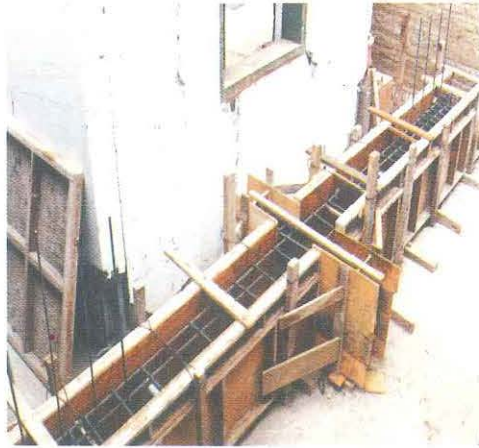
Foto 1. Encofrado de la viga de cimentación. Se aprecian las espigas.
