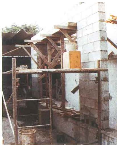
Foto 4. Pórtico antes de ser rellenado con grout.
