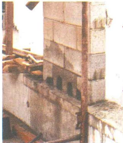
Foto 3. Registros de limpieza en la primera hilada.
