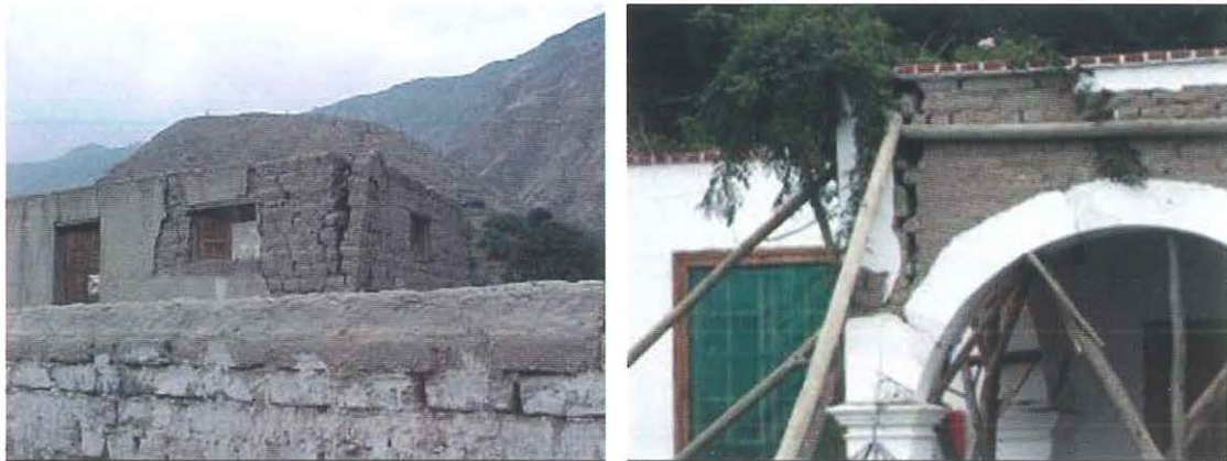
Foto 8. Desplomes excesivos en muros de adobe: a) Arequipa 2001, foto D. Quiun. y b) Chincha 2007, foto D. Torrealva.
