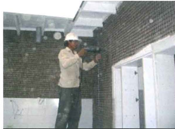
Foto 18. Perforación de la pared cada 30 cm. horizontal y vertical con broca de 3/8":a) Taladro y b) Perforación del muro. Foto D.Torrealva.
