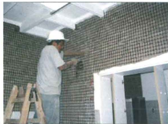
Foto 19. Colocación de la malla en ambos lados: a) Presentación de la malla y b) Fijación provisional con clavos doblados. Foto D.Torrealva.
