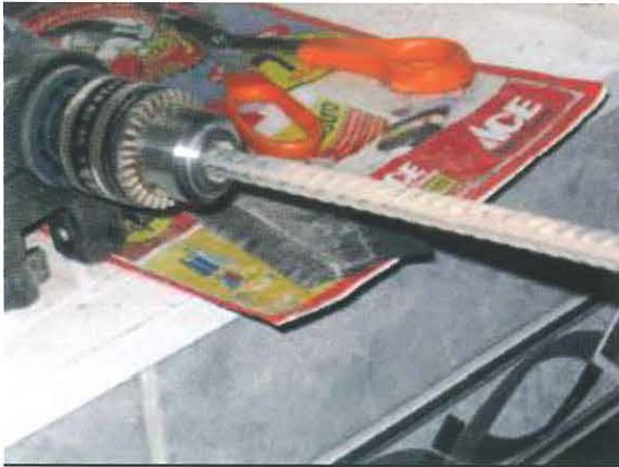
Foto 18. Perforación de la pared cada 30 cm. horizontal y vertical con broca de 3/8":a) Taladro y b) Perforación del muro. Foto D.Torrealva.
