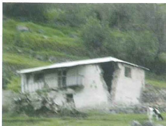
Foto 9. Colapso parcial de muros sin caída de techo: a) Lima, foto J.Vargas y b) Cusco 1985, foto D.Torrealva.
