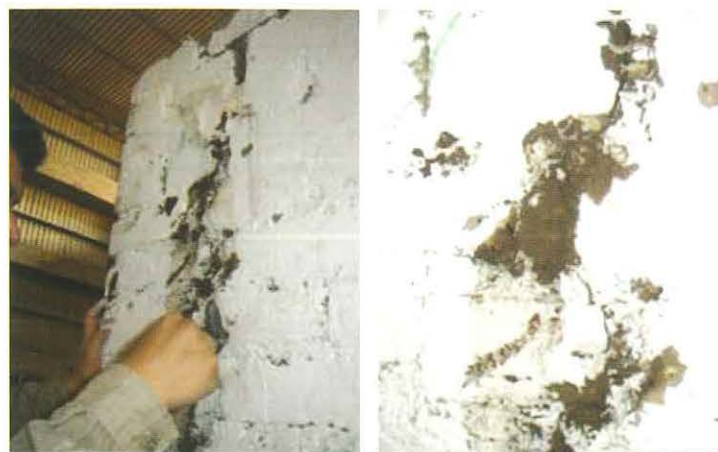
Foto 13. a) Retiro de sello de yeso y b) Retoque de superficie exterior. Foto C. Iwaqui
