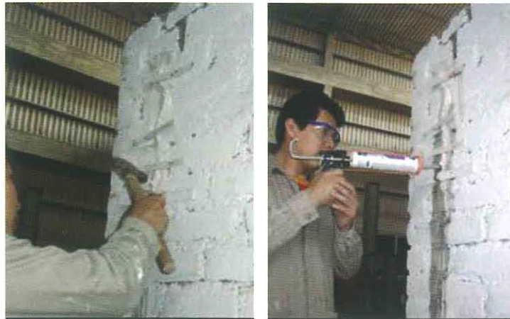
Foto 11. a) Sellado de caras de fisuras con yeso y b) Inyección de agua. Foto C. Iwaqui
