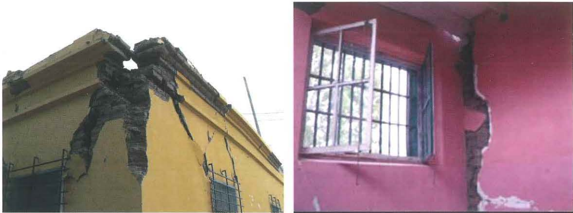
Foto 7. Grietas anchas y extensas en muros de adobe: a) Chincha 2007, foto D.Torrealva y b) Canete 2007, foto D.Torrealva.
