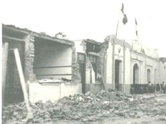
Foto 9. Colapso parcial de muros sin caída de techo: a) Lima, foto J.Vargas y b) Cusco 1985, foto D.Torrealva.
