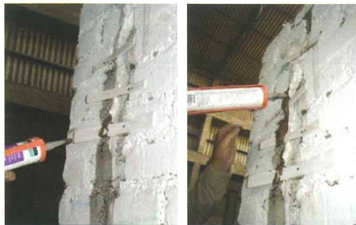
Foto 12. a) y b) Inyección de Grout. Foto C. Iwaqui.
