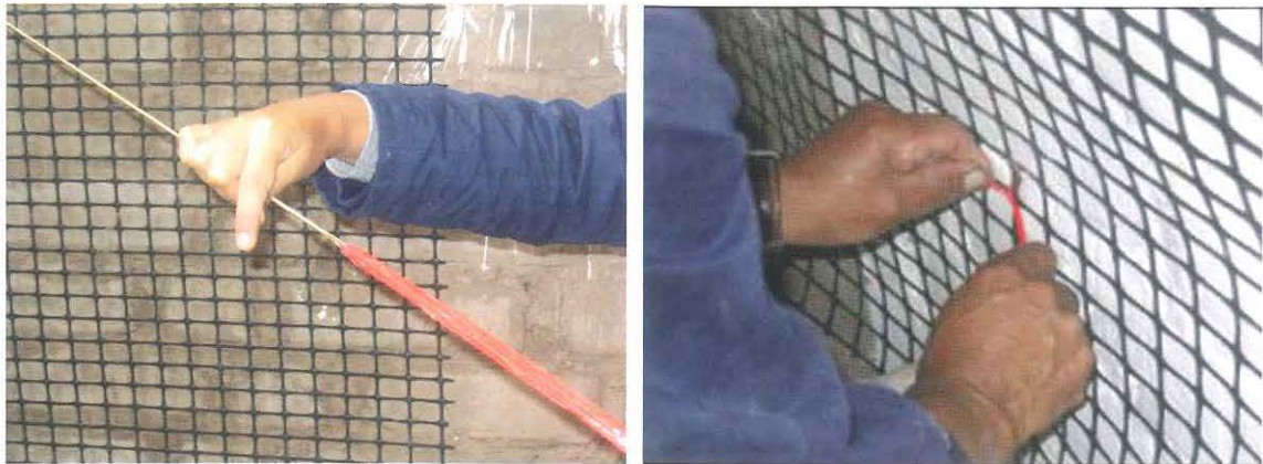
Foto 20. Amarre de la malla con hilos de paja o rafia a través de los agujeros: a) y b) Fijación de la malla. Foto D. Torrealva.
