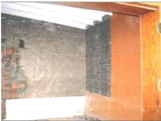
Foto 19. Colocación de la malla en ambos lados: a) Presentación de la malla y b) Fijación provisional con clavos doblados. Foto D.Torrealva.
