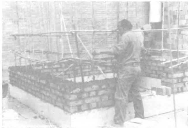
Figuras 3 y 4. Colocación del refuerzo de caña.
